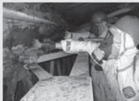
吹付け石綿の除去作業の様子
