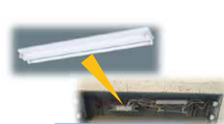
蛍光灯安定器
