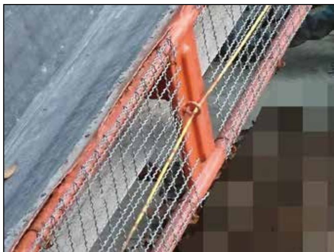
図表3 バルコンの端部を金網で養生
