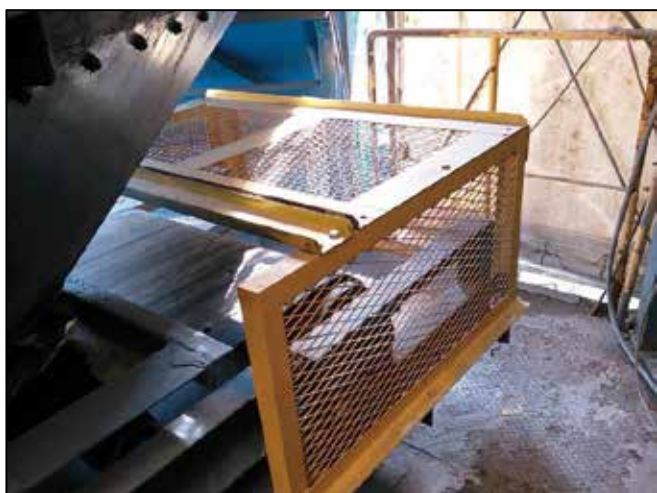
図表3 バルコンの端部を金網で養生
