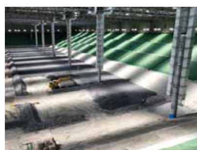
被覆施設棟内東側 (浸出水集排施設、保護砕石)
