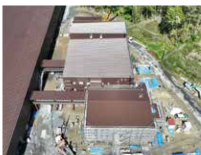
管理棟、浸出水処理施設棟
