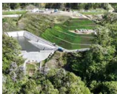
搬入車両駐車場・ 防災調整池（西側より）
